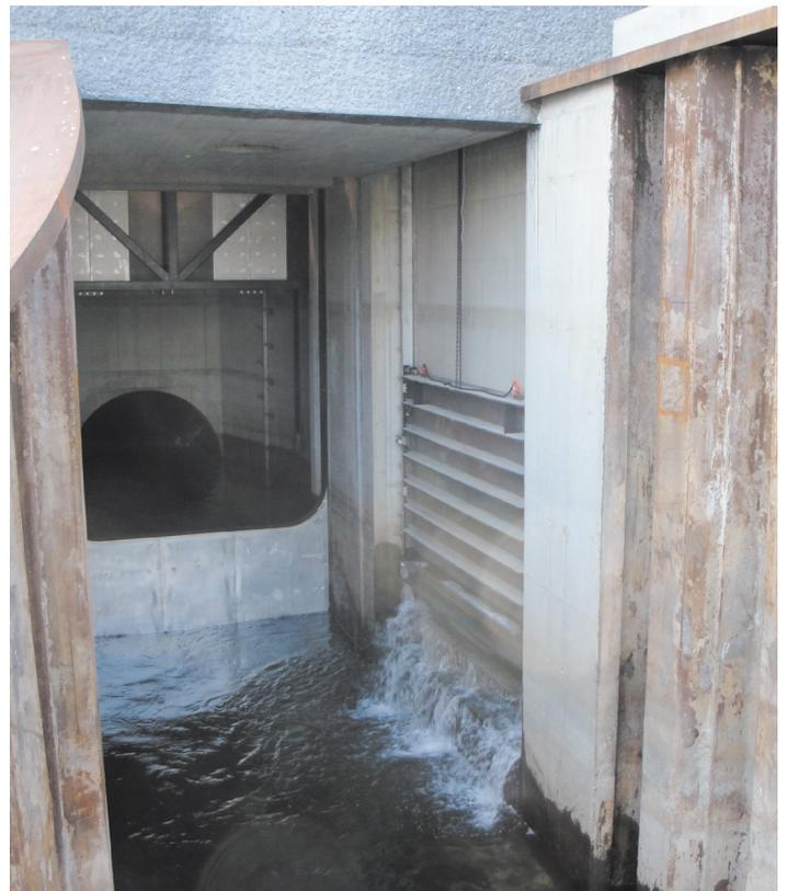
du réseau en amont et tout risque d'inondation. Ce système est particulièrement adapté pour les déversoirs d'orage situés près des milieux récepteurs, susceptibles en période de hautes eaux, de pénétrer dans le réseau d'assainissement et-ou dans le réseau d'eaux pluviales.
