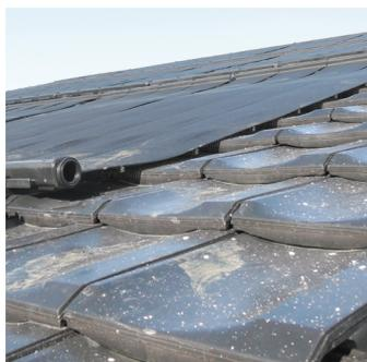
Pour la plupart des installations géothermiques sur sondes, la température du sol décroît de manière significative sur le long terme. Ceci a comme conséquence une dégradation progressive des performances des pompes à chaleur et une hausse des consommations électriques. Un procédé consistant à recharger le sous-sol en calories solaires est opportun car il permet d'obtenir des performances énergétiques élevées et durables. BSR technologies propose donc de recharger
