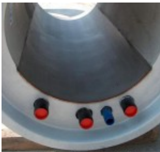
Echangeur de chaleur en place dans la canalisation
